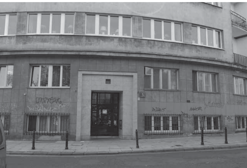
Wejście do budynku przy ul. Bartoszewicza 1A, w którym mieszkał Jerzy Ignatowski „Obrzynek”.
