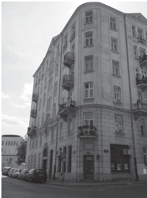
Oboźna 11. Na piątym piętrze (cztery okna od prawej) było mieszkanie Jarosława Markiewicza.
