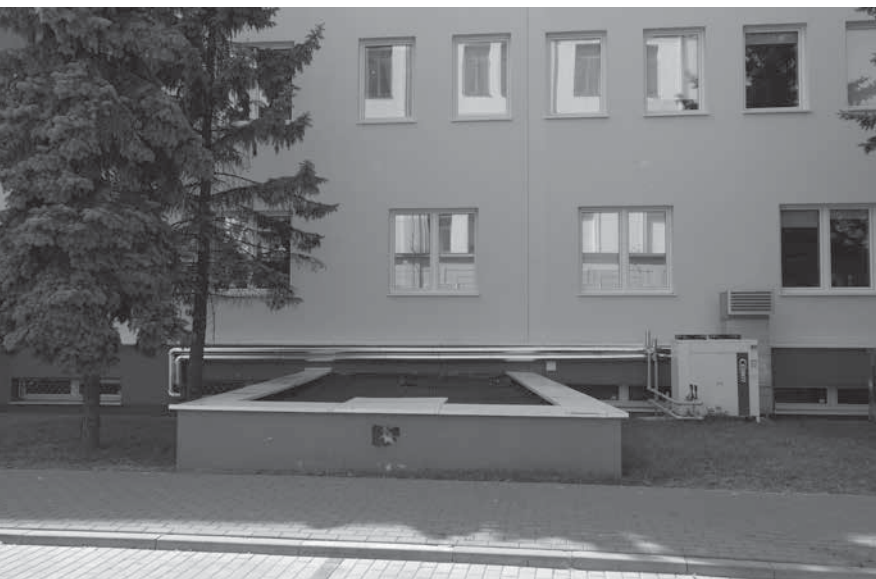
Instytut Matki i Dziecka przy ul. Kasprzaka 17A. Nieistniejące już wejście do podziemi, w których mieściła się drukarnia. Dziś prowadzące w dół schody zostały zabudowane.
